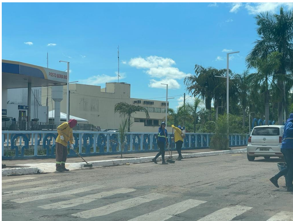
FIGURA 26 – SERVIÇO EXECUTADO PELA SECRETARIA MUNICIPAL DE INFRAESTRUTURA.
