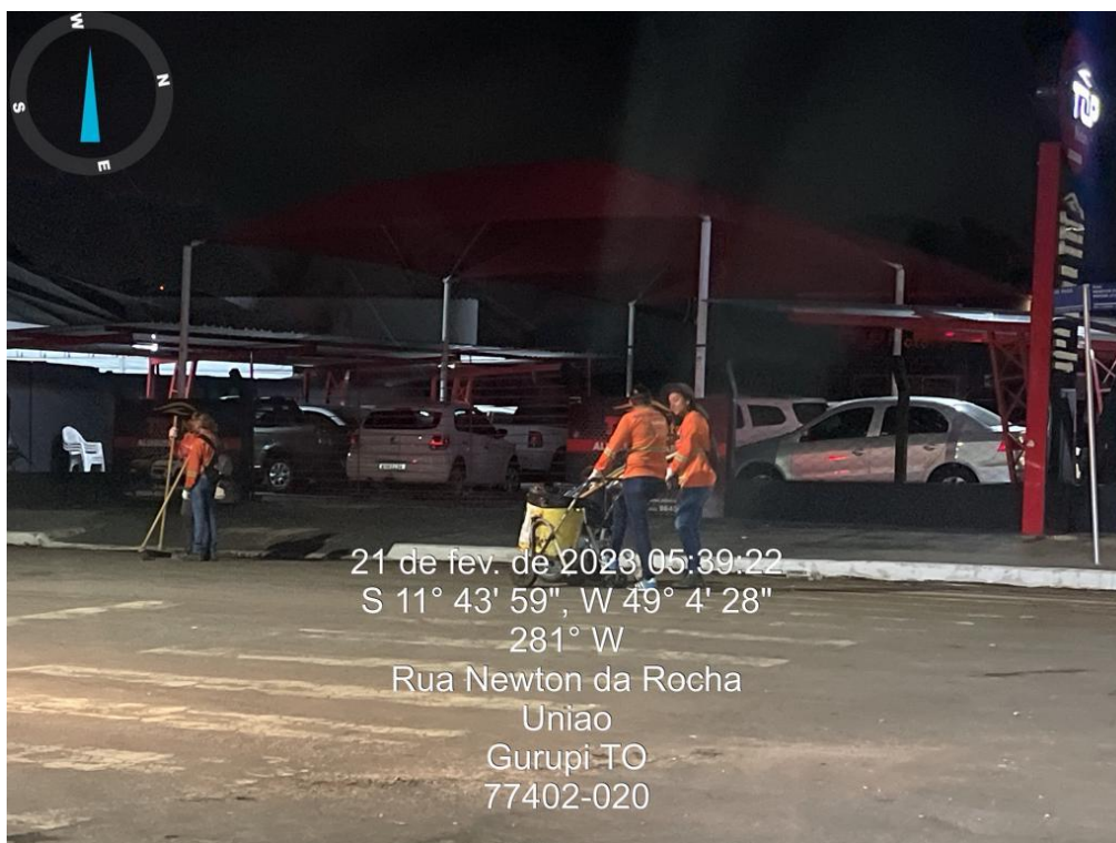
FIGURA 25 – SERVIÇO EXECUTADO PELA SECRETARIA MUNICIPAL DE INFRAESTRUTURA.
